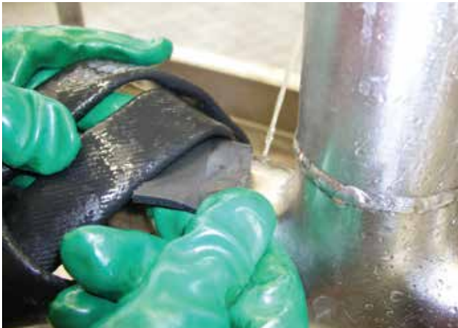
Fiksu paikkausletkujärjestelmä
