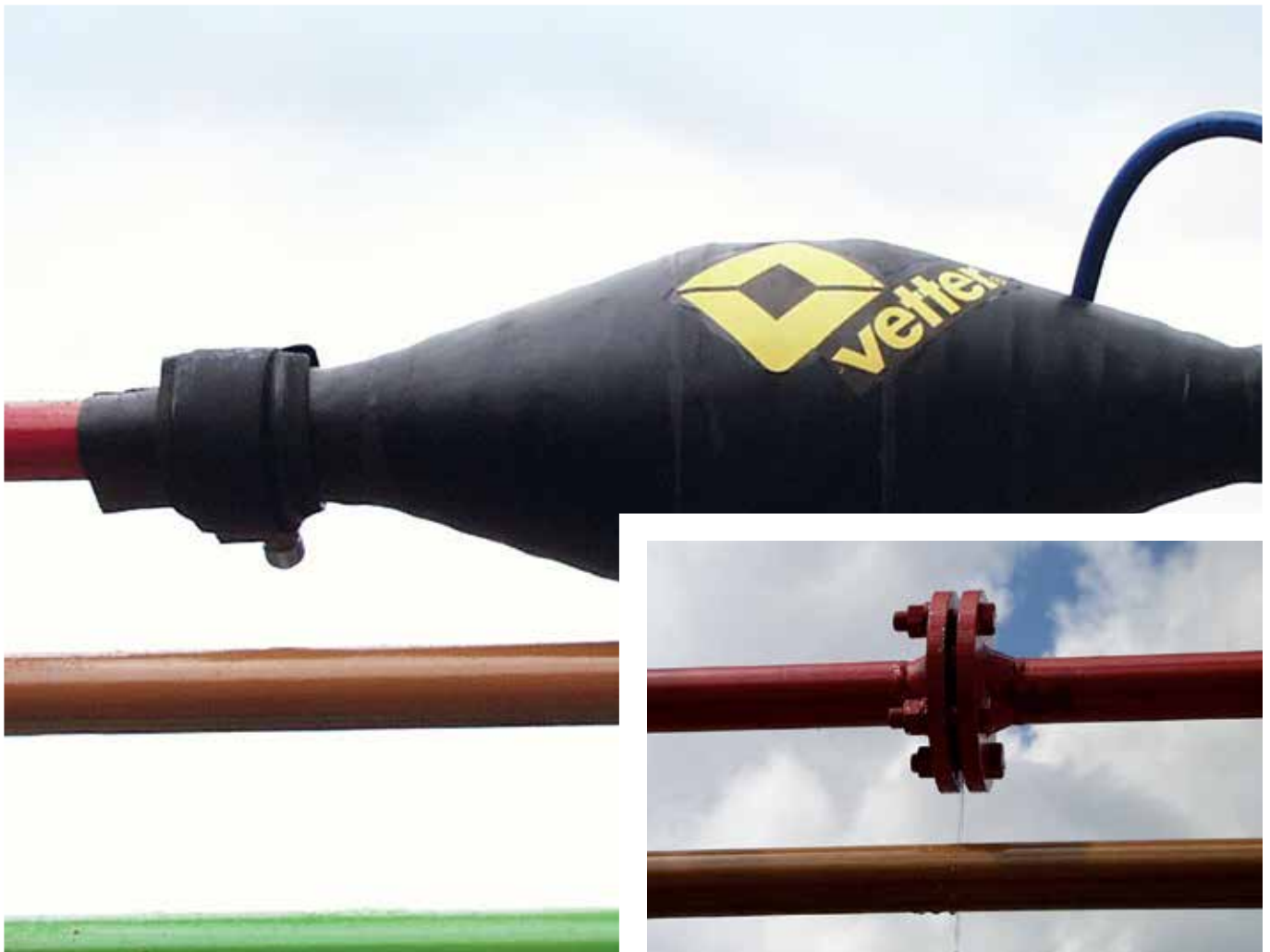
Vuoto putken laipassa
